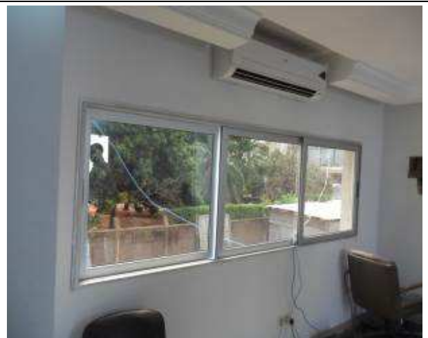
Photo 2: fenêtre en aluminium dans un bureau
