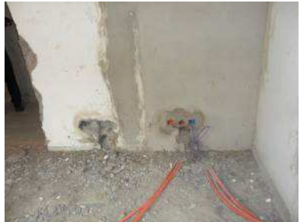
Photo 6 : tubage pour électricité en cours
