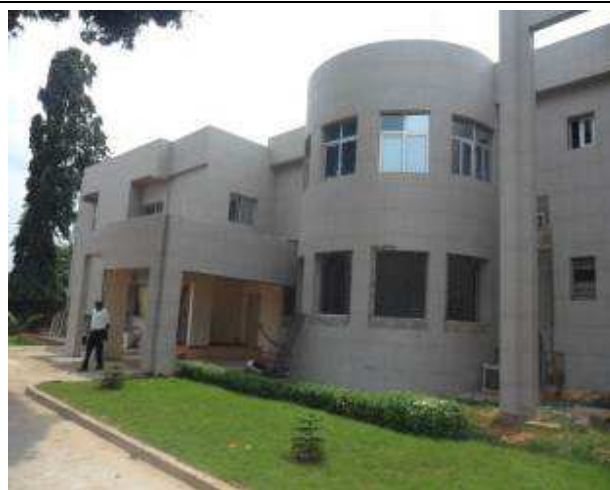
Photo 1: vue de la façade sud du bâtiment achevé
