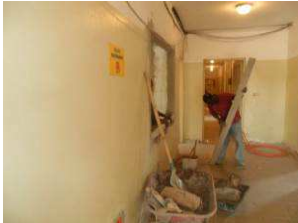
Photo 3 : dressage en maçonnerie des bords de fenêtre en cours
