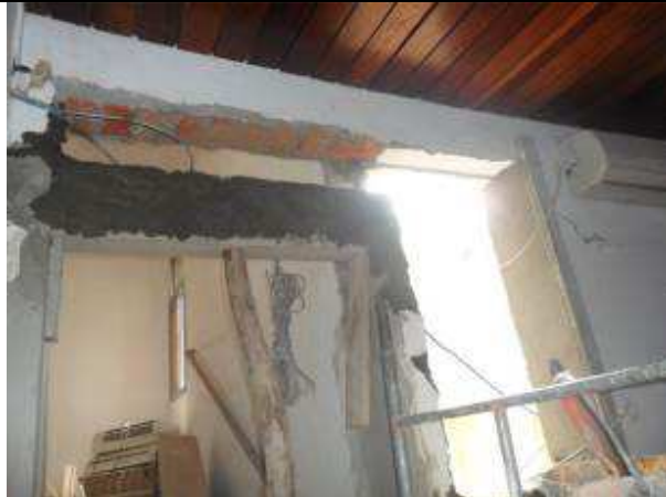
Photo 5 : enduit ciment sur mur
