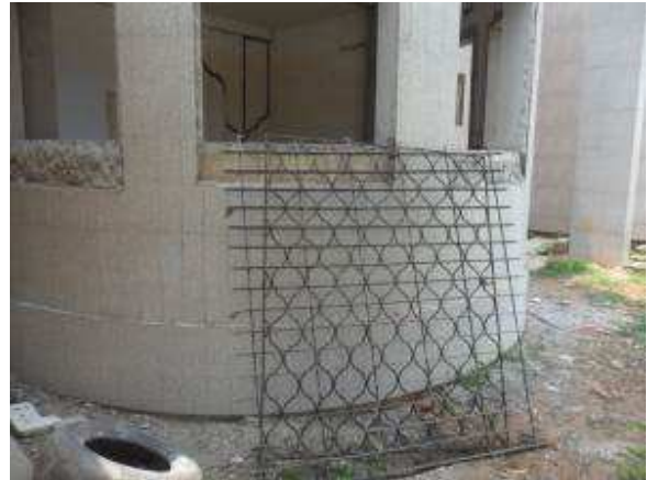
Photo 4 : dépose de grille métallique pour fenêtre au RDC
