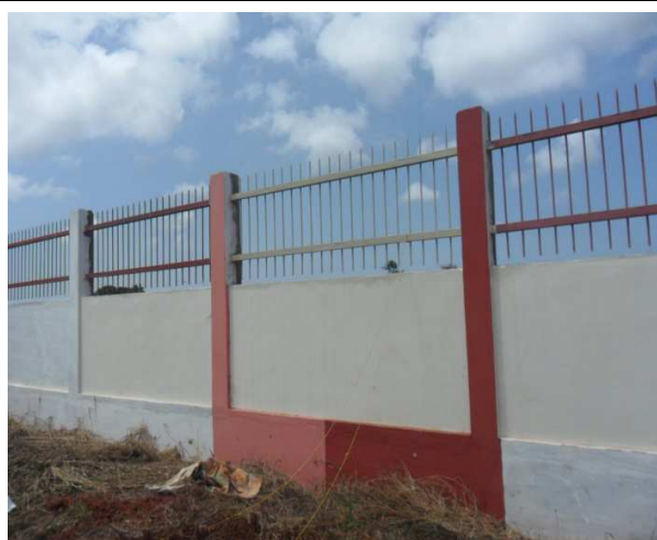
Photo 1: façade sud de la clôture surélevée de grille en fer forgé
