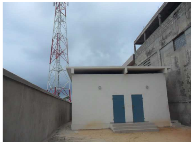
Photo 2: local abritant les équipements du poste d'Ablogamé
