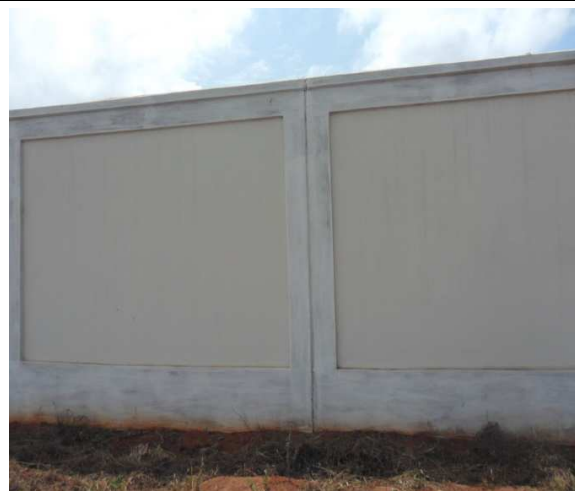
Photo 2: façade Est de la clôture en maçonnerie
